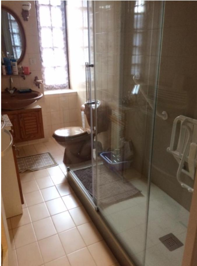
*Remplacement de la baignoire existante par un receveur de douche extra plat, d'un siège de douche rabattable et d'une barre de maintien*
